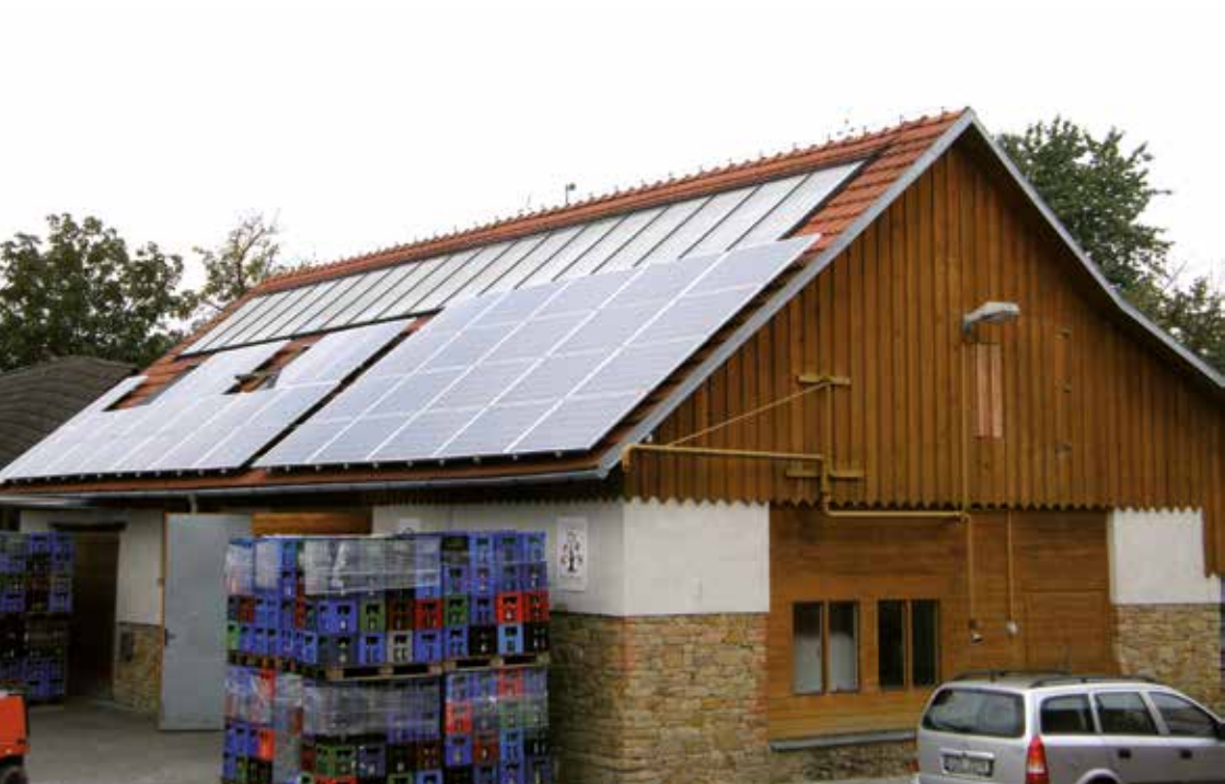
Solární kolektory na teplou vodu a FVE na moštárně v Hostětíně ((z archivu z.s. Calla)
