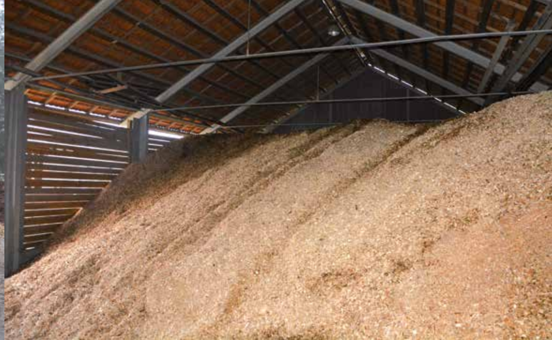
Obecní výtopna v Hostětíně využívá dřevní odpad z blízkých lesů (z archivu z.s. Calla)
