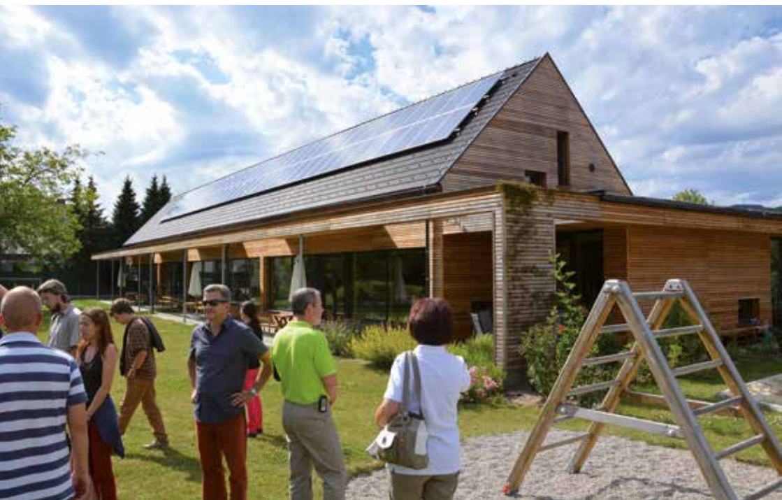
Podařené instalace FVE na střechách domů budí zájem návštěvníků (z archivu z.s. Calla)
